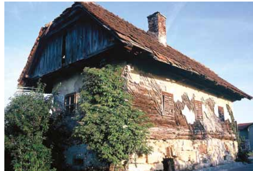
Slika 4: Propadajoča cimprana hiša na Destrniku št. 6 (foto: Milko Rojs, 2005)
