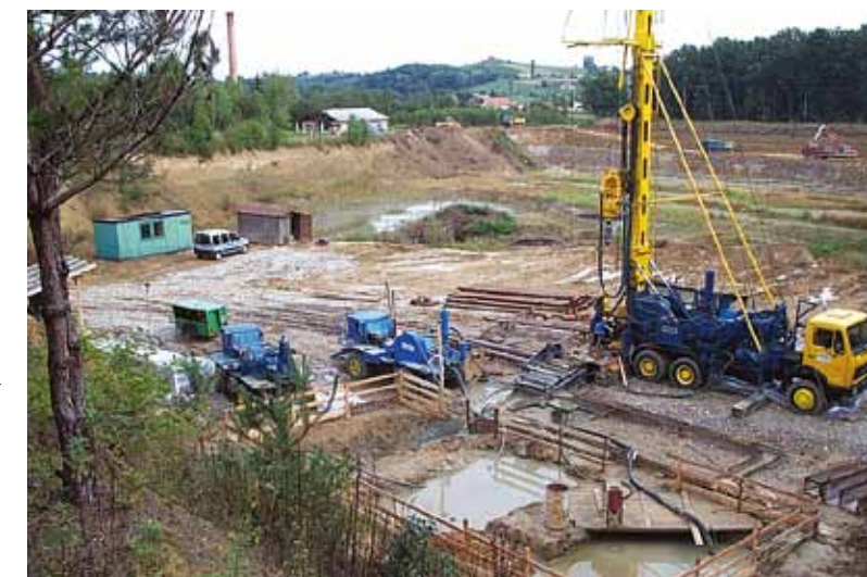
Slika 1: Vrtalni stroj na delovišču v opuščnem glinokopu v Janežovcih
